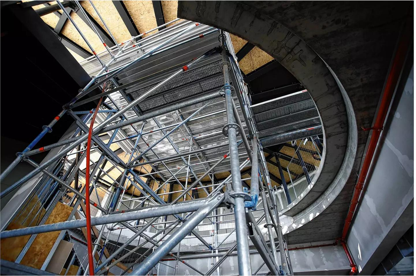
Erst wurde ein rechteckiges, etwa 100 Quadratmeter großes Stück aus dem Dach geschnitten, um dann eine Rundung für den Treppenaufgang auf das Dach des Lago einzufügen. | Bild: Scherrer, Aurelia
